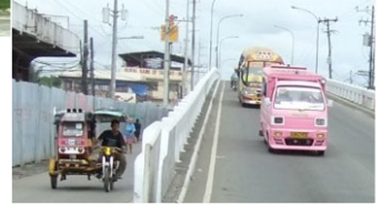
Flyover-sillat (keskikaistat korotettu yli risteysten) mahdollistavat poikittaisliikenteen esteettömän kulun alitse. Pukin pakettiko kyydissä?
